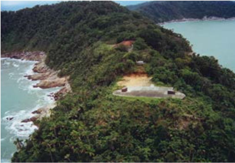
Vista da Ponta do Jurubatuba com a respectiva bateria
