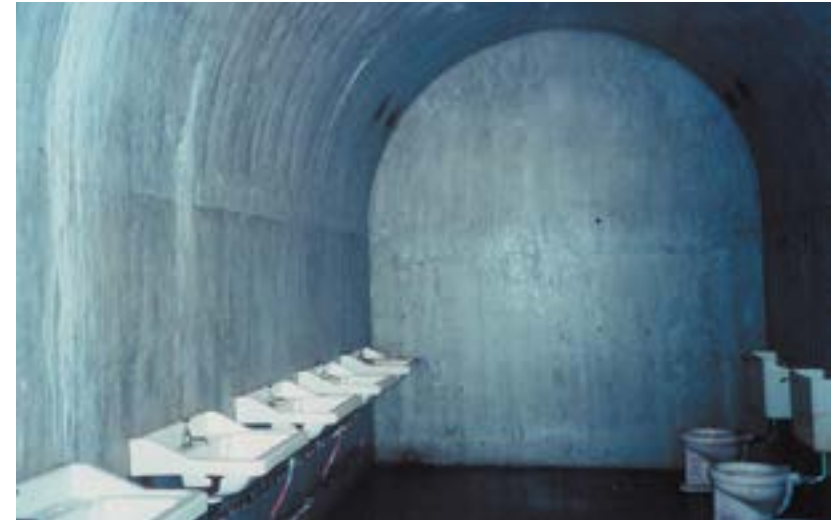
Vista das instalações subterrâneas do Forte dos Andradas
