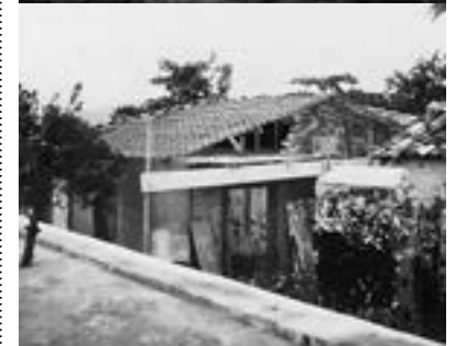
“Casa-Caiçara” de pau-à-pique incorporada aos restos do quartel do Forte São João, que foi demolida em 1942 e a construção da residência do caseiro no mesmo local.
