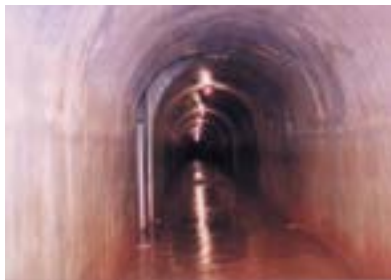
Vista das instalações subterrâneas do Forte General Rego Barros que ficou inacabado
